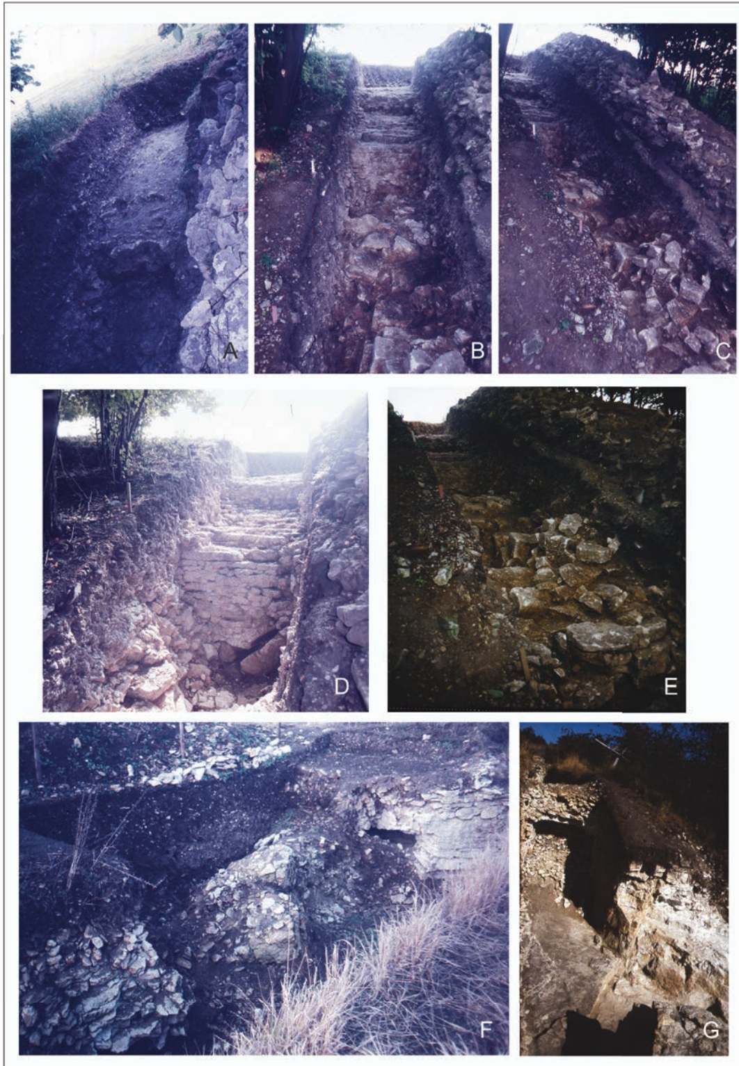
Obr. 17: A–E sonda na severním okraji plošiny od severu a severozápadu; F - rozšíření v úseku 4–8 v jižní sondě; G - „vstupní partie“ v opukovém bloku a zachovalá klenba v jižní sondě od jihu (vše foto A. Štrof 1982–1984).
