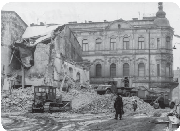
81 Moravská Ostrava. Demolice historické zástavby domovního bloku Velká – Dlouhá – Muzejní – Pivovarská, šedesátá léta 20. století. Archiv Města Ostravy.
