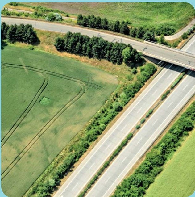
159 Třebestovice (okr. Nymburk): křížování zaniklých a současných silnic . Foto: Martin Gojda.
