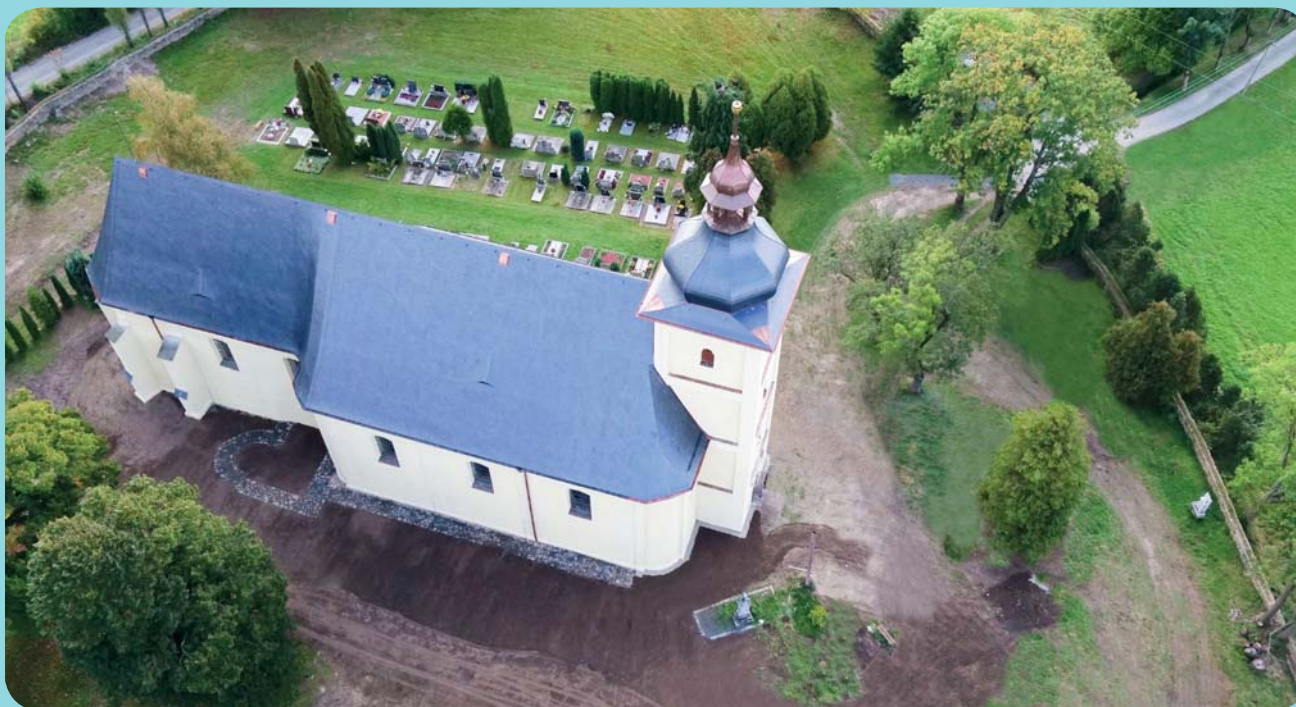
106 Staré Město (okr. Bruntál), kostel Neposkvrněného početí Panny Marie. Prezentace průběhu zdiva románské stavby při severozápadní stěně kostela. Foto: Jindřich Hlas.
