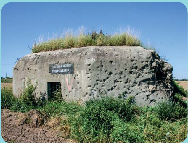
156 Opava-Jaktař. Československé pohraniční železobetonové lehké opevnění vz. 37 , objekt III/309/A-120Z, vzdálený cca 230 m jihozápadně od archeologicky zkoumaného bojového postavení Rudé armády. Stopy střelby svědčí o využití pevnůstky německou armádou v dubnu roku 1945. Foto: Pavel Malík.
